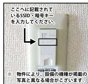
無線ルータが壁面に埋め込まれてありますので、記載されているSSID、暗号キーをご利用になりたいスマートフォン・タブレット・パソコンに設定していただければ、無線接続によるインターネットが利用可能です。
